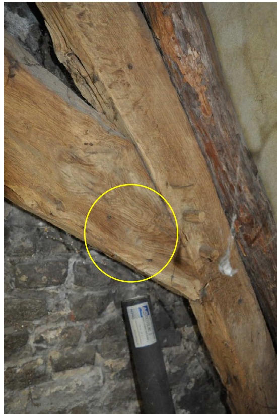
44 Telmerk met twee eitjes op het meest westelijke spant.
