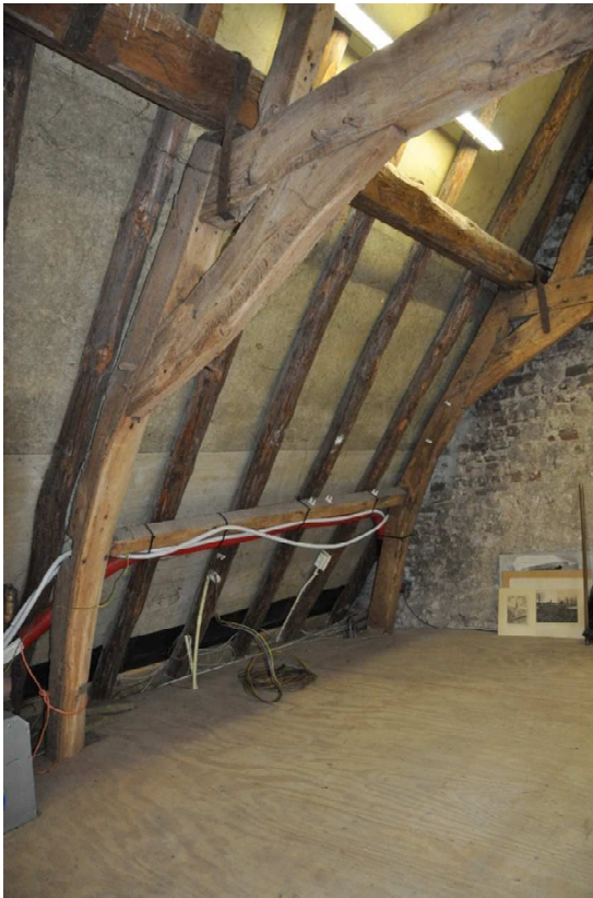
43 Ingepende gording tussen de spantbenen van de twee oostelijke spanten (noordzijde).
