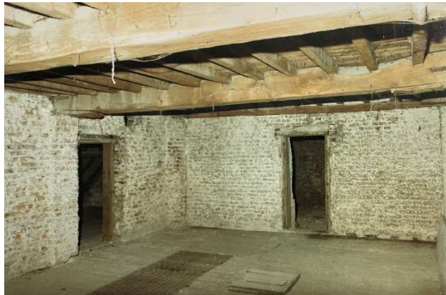
54 De tweede verdieping na het verwijderen van het stucwerk, tijdens de restauratie in 1988, gezien richting toren.
