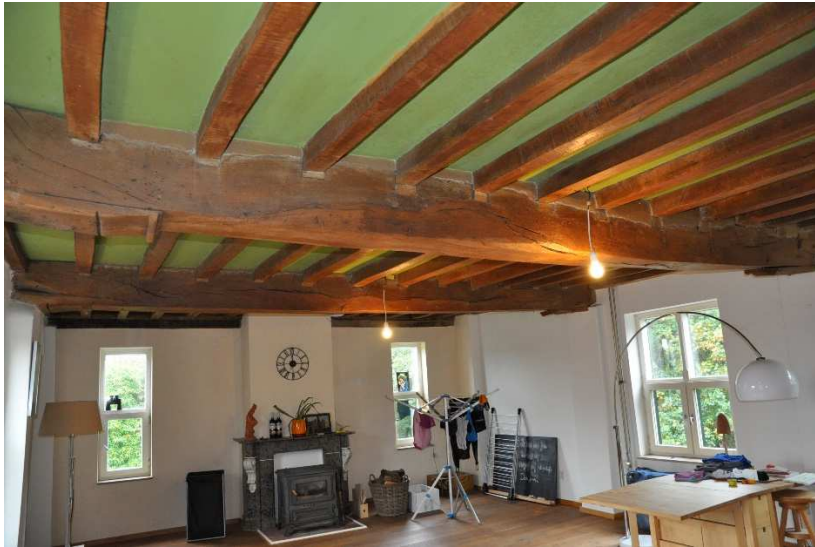
50 De balklaag boven de eerste verdieping van de zaalbouw.
