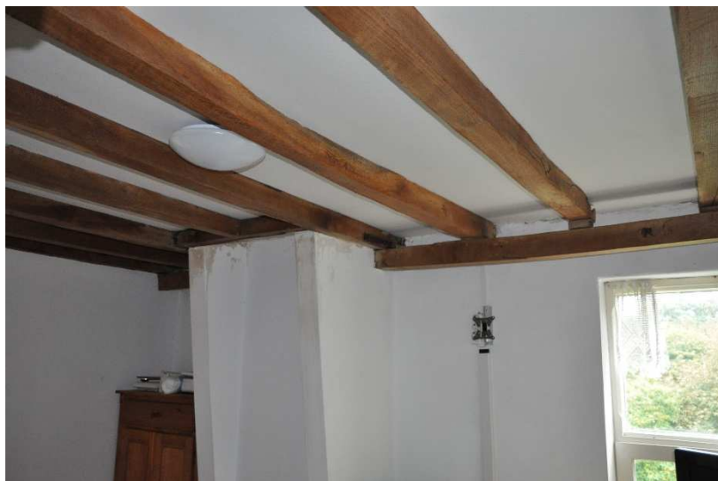
55 De strijkbalk en raveling tegen de oostgevel van de zaalbouw.
