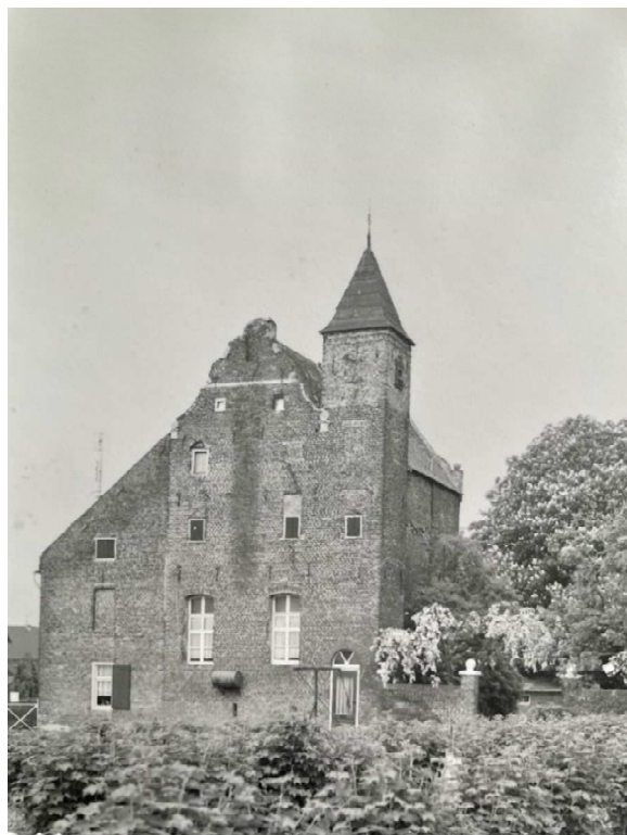
7 De oostgevel van De Thooren, vóór restauratie.
