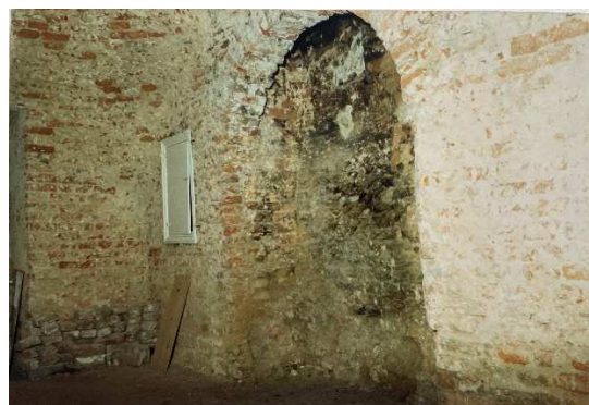
33 De ontleisterde hal, met haardopening in de noordgevel, 1988.
