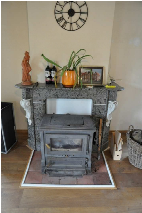
53 De herplaatste marmeren schouwmantel in de zaal op de eerste verdieping.
