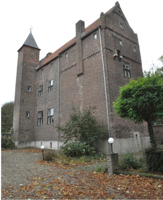
19 De noord- en westgevel van De Thooren.
