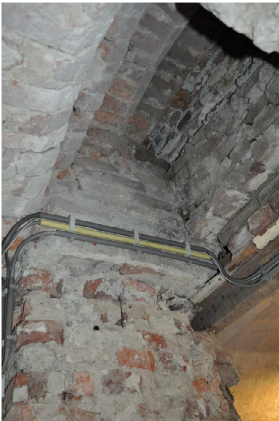
29 Oorspronkelijke keldertoegang of vensteropening van de woontoren, aan zijde van de zaalbouw.
