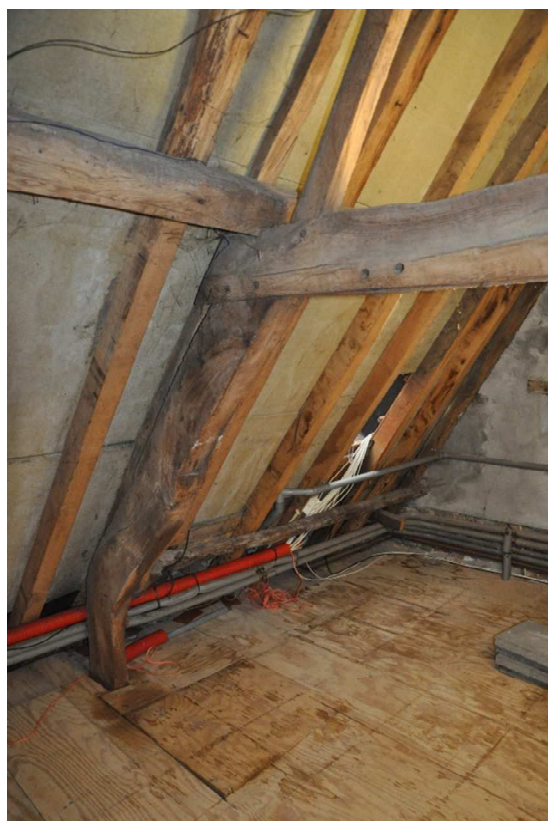
60 Noordelijke spantbeen van het oostelijke spant, waarbij het korbeel verdwenen is.
