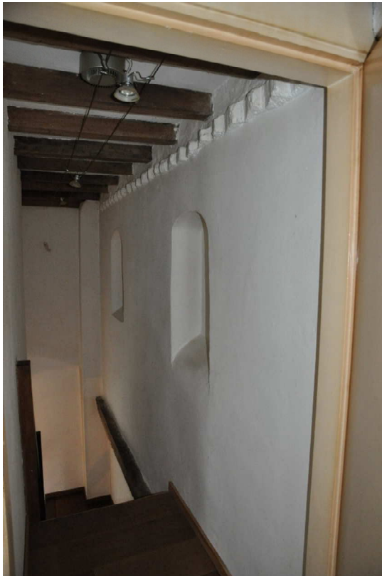
38 Dichtgezette vensters en een tandlijst in de oostgevel van de woontoren, gezien vanuit de zaalbouw.
