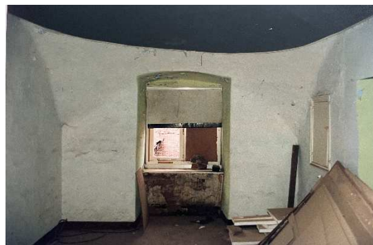
32 De hal bij aanvang van de werkzaamheden rond 1988.
