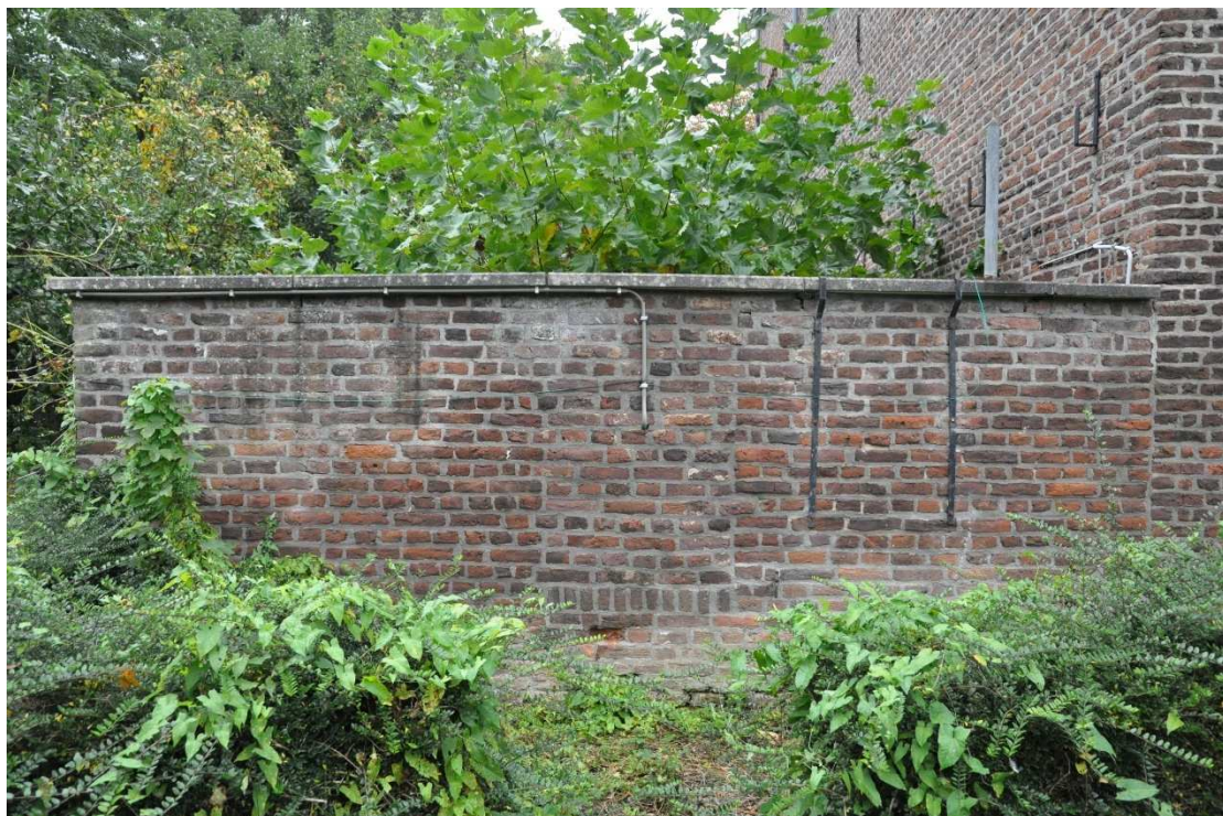
23 Het oostelijke deel van de tuinmuur, het restant van de zuidelijke aanbouw. In het midden een dichtgezet venster.
