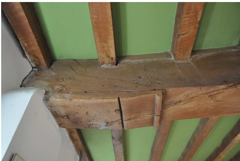
52 Eén van de ojiefvormige sleutelstukken op de eerste verdieping.
