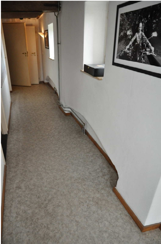
58 De spaarbogen zijn nog zichtbaar in de gang op de 2 e verdieping.
