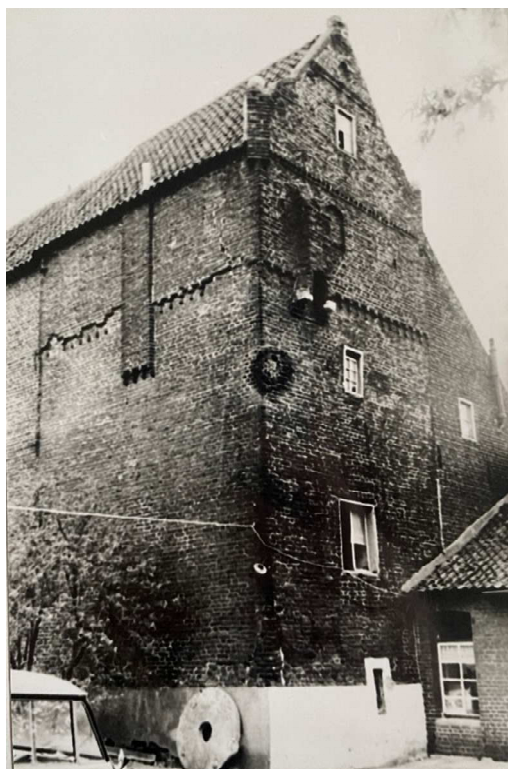
6 De westgevel vóór de restauratie.
