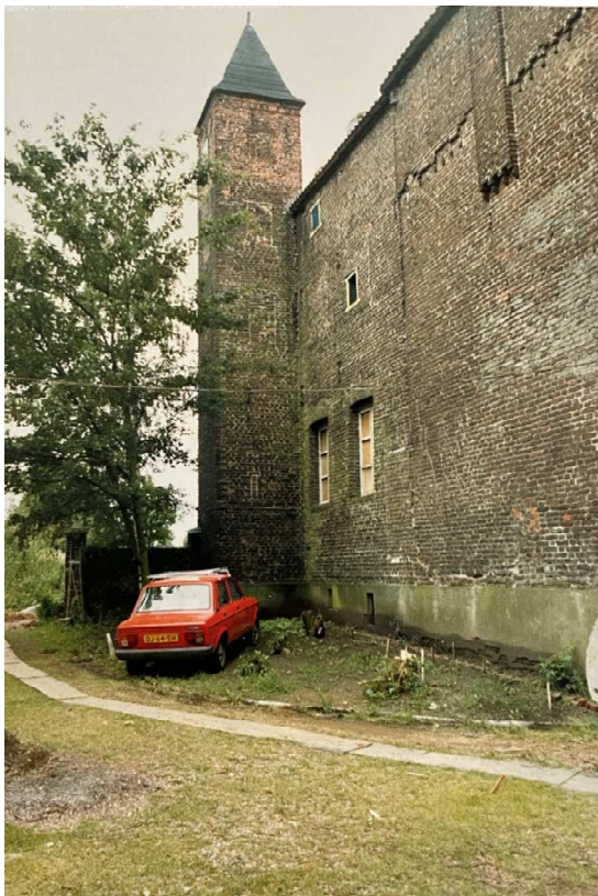
14 De noordgevel van de zaalbouw en de toren vóór de restauratie.
