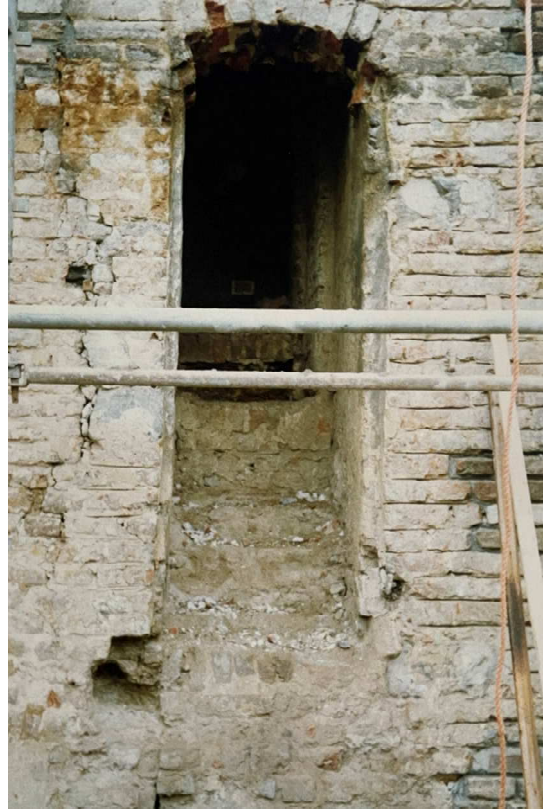
10 De oorspronkelijke toegang van de woontoren, vrijgelegd in 1988, met segmentboogbeëindiging.
