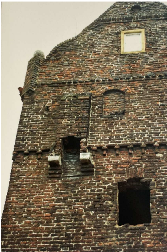
17 Een vergroot venster (1 e verdieping), de oorspronkelijke uitbouw van de latrine en een dichtgezet venster (2 e verdieping) in de westgevel van de woontoren.
