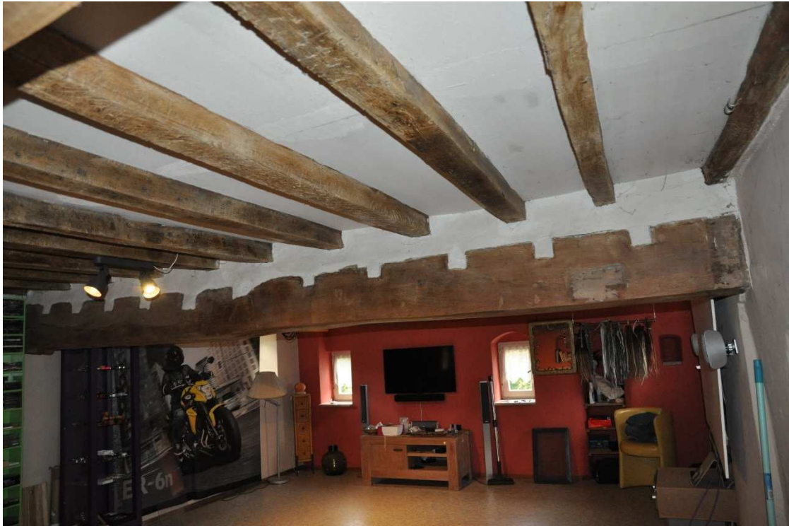
37 De kamer op de tweede verdieping van de woontoren, richting westgevel. De kinderbinten zijn verhoogd opgelegd om de stahoogte te vergroten.
