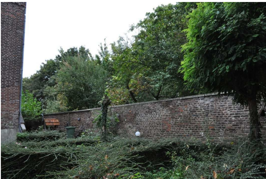
26 De binnenzijde van de tuinmuur (vroeger binnengevel).
