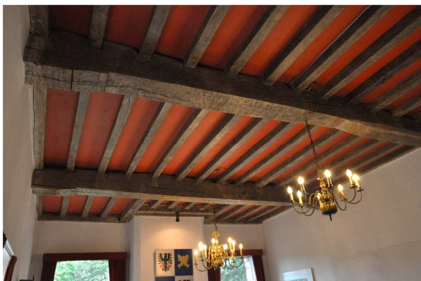
46 De balklaag boven de begane grond van de zaalbouw.
