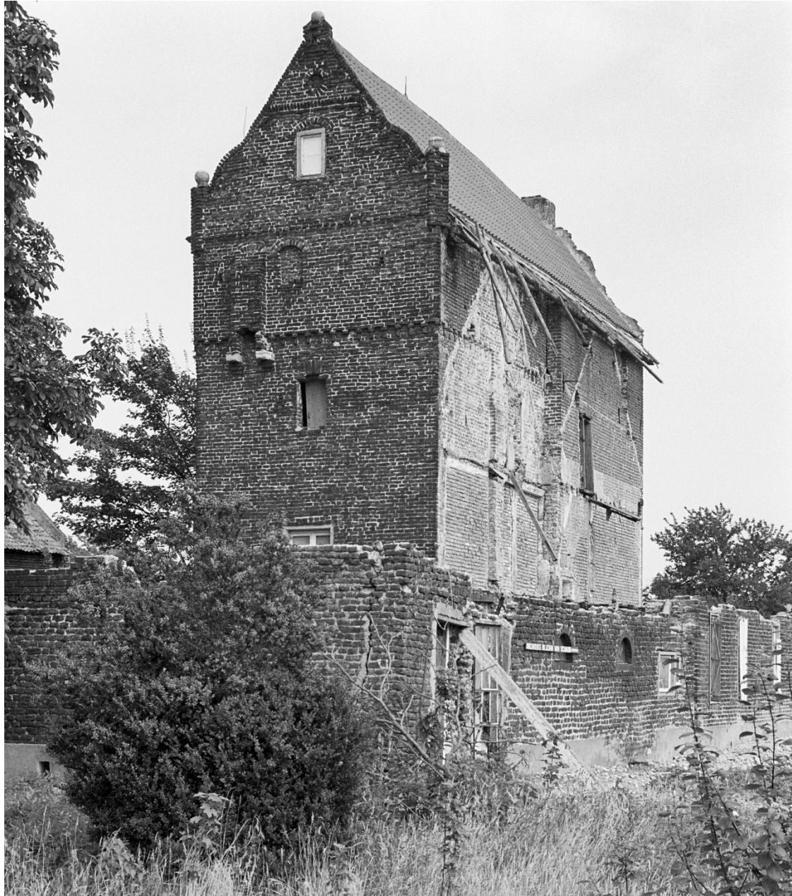
16 De westgevel van de woontoren en de zuidgevel van het gehele gebouw na sloop van de aanbouw maar vóór de restauratiewerkzaamheden.
