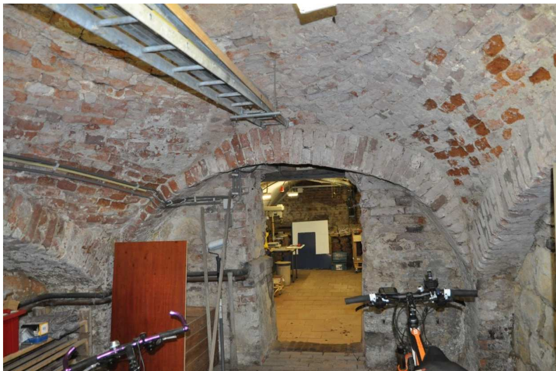
27 De kelder onder de woontoren met bakstenen koepelgewelf, gezien richting de kelder van de zaalbouw.
