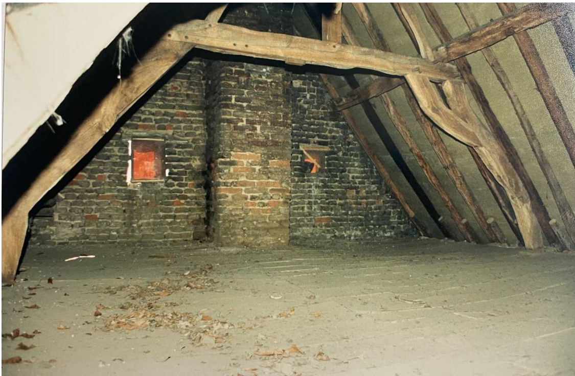
62 De kapconstructie van de zaalbouw (oostelijke spant) vóór de restauratie.
