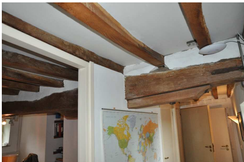
56 De meest westelijke moerbalk is versterkt met een eiken slof, vanwege doorbuiging.
