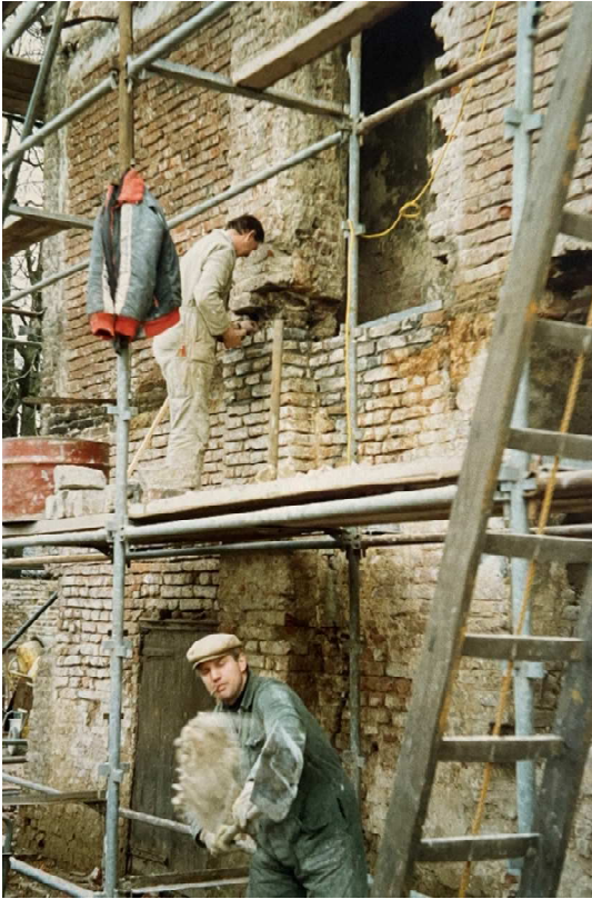
9 Werkzaamheden aan de zuidgevel van de woontoren, links de oude kelderdeur.
