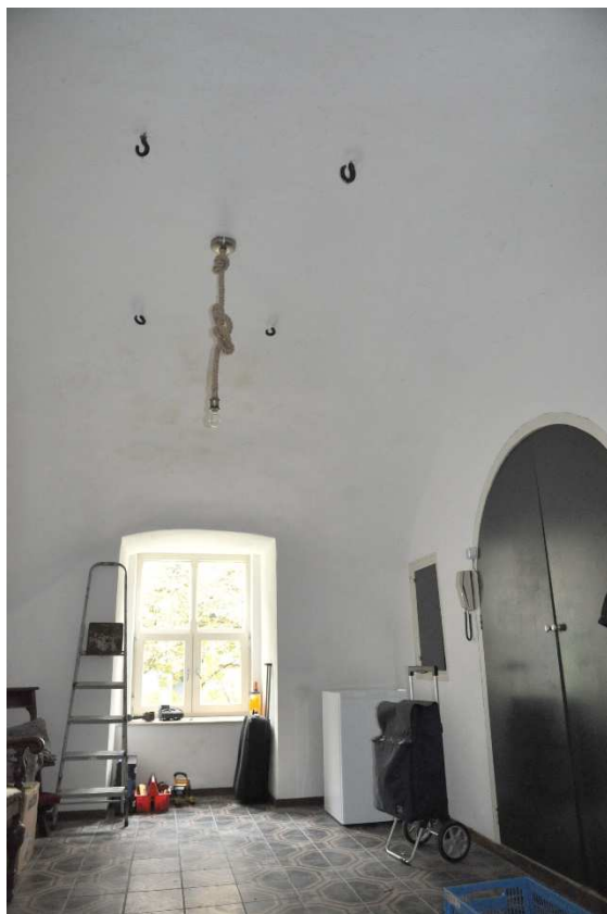
31 De kamer/hal op de begane grond, rechts de voormalige haard, nu verbouwd tot meterkast.
