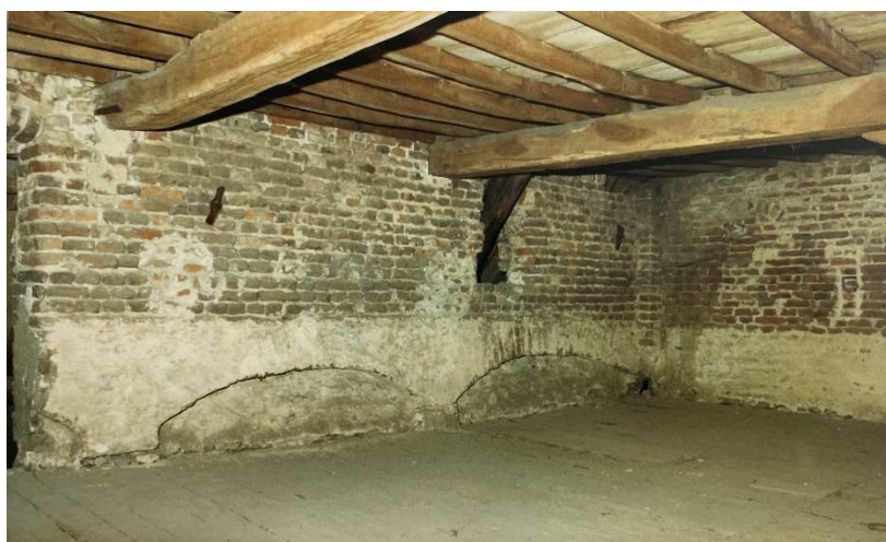
57 Gemetselde spaarbogen in de zuidgevel van de zaalbouw, tijdens restauratie.
