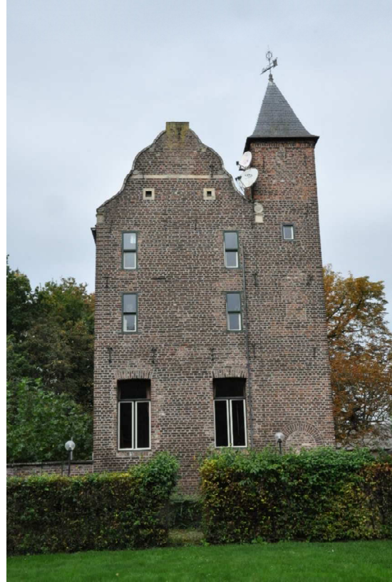
20 De oostgevel van de zaalbouw.
