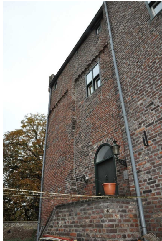
22 De zuidgevel van de woontoren met trap uit 1988.
