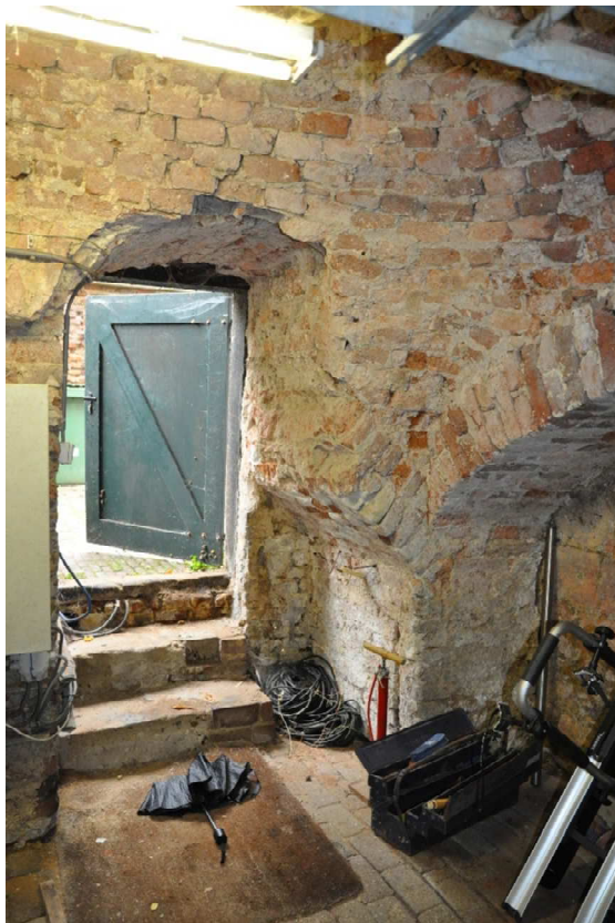
30 De later aangebrachte toegang van de kelder onder de woontoren, uitgehakt in de gevel en het gewelf.
