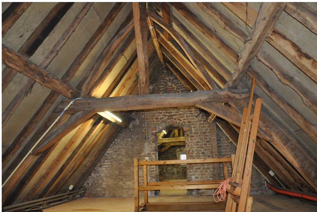
59 De kapconstructie van de zaalbouw, gezien richting de woontoren.
