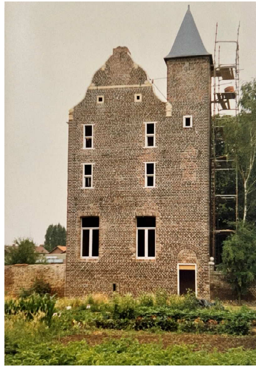
13 De oostgevel vlak na restauratie.
