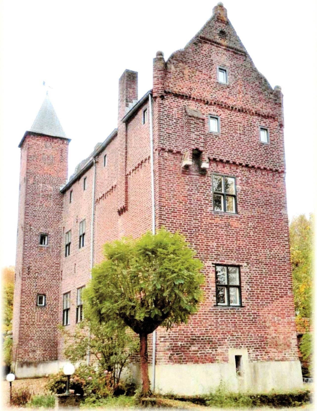
Op de voorgrond de westgevel, de oorspronkelijke woontoren uit de veertiende eeuw met de gezwenkte gevel en twee pinakels bekroond met bollen. Het uitgebouwde gemak is duidelijk te zien. De uitkragende stenen zijn restanten van de kantelen en daar zich bevindende weergang. Opvallend zijn de oorspronkelijke kleine vensters. Hier zien we bouwsporen, de oorspronkelijk ramen hadden een boogvorm. Onder aan de westgevel bevindt zich een verticale beluchtingsgat voor de grotendeels boven het maaiveld gelegen kelder. Links van de regenpijp aan de noordgevel zien we de uitbouw met torentje uit de zeventiende eeuw. Foto: Inge Pelsers Makelaardij/Anne Hoeijmakers. Vervolg blz. 8 >
