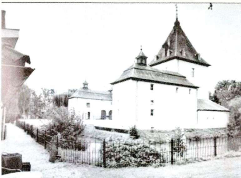
Kasteel Rijkholt (Eijsden). De woontoren met het tentdak dateert van omstreeks 1300. De met breuksteen opgebouwde onderbouw verwijst naar zijn hoge leeftijd. De beide hoekpaviljoens dateren van de achttiende eeuw. Bron: W. Hupperetz, Kastelen in Limburg.
